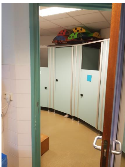
Afbeelding: Niet alle verlichting in kleedkamers, bergkasten, toiletruimten of keukens schakelt automatisch weer uit. Overweeg het plaatsen van een bewegingsmelder in deze ruimten met een maximale nabrandtijd van 10 minuten.
