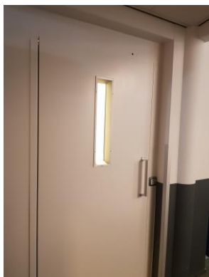
Afbeelding: In de lift blijft continu het licht aanstaan, overweeg een bewegingsmelder te plaatsen
